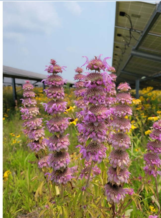
LGE-KU Solar Site
